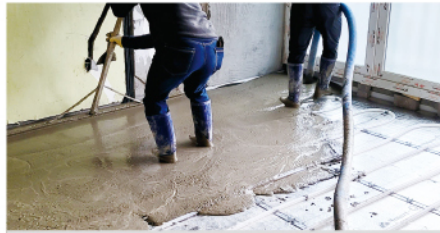
방통 몰탈 시공
