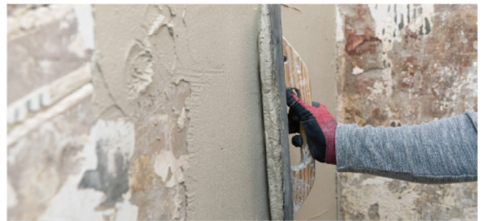
대형 건물·각종 건축물 등 넓은 면적의 벽면 시공
