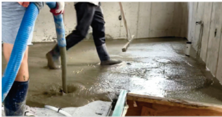
방통 몰탈 시공
