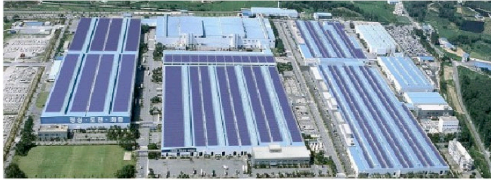
르노삼성 자동차 부산공장 태양광 발전 주차장 공사
