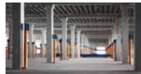
덕평 휴메드 물류창고 신축공사
