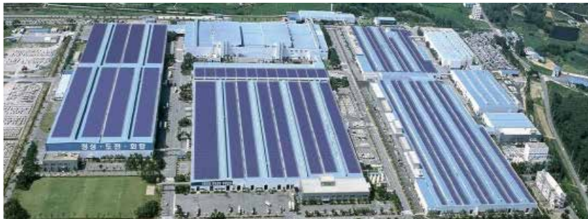
르노삼성 자동차 부산공장 태양광 발전 주차장 공사
