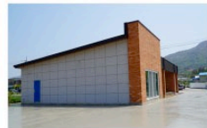
전남 고흥군 금산면 노인 복지시설 신축공사 현장
