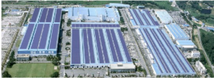
포도산성 지동차 부산공장 대안공 별천 주차장 공사
